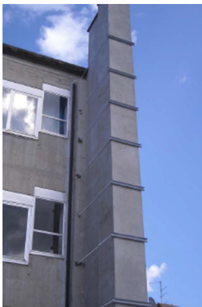
Fig. 4. Dispositivi di pronto intervento sulla canna fumaria
