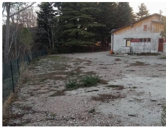
Figura 6: Vista dell'area cortiliva lato Nord
