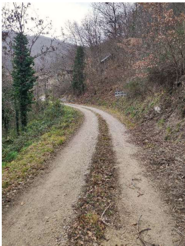
Figura 12: Strada di accesso a fondo naturale in ghiaia
