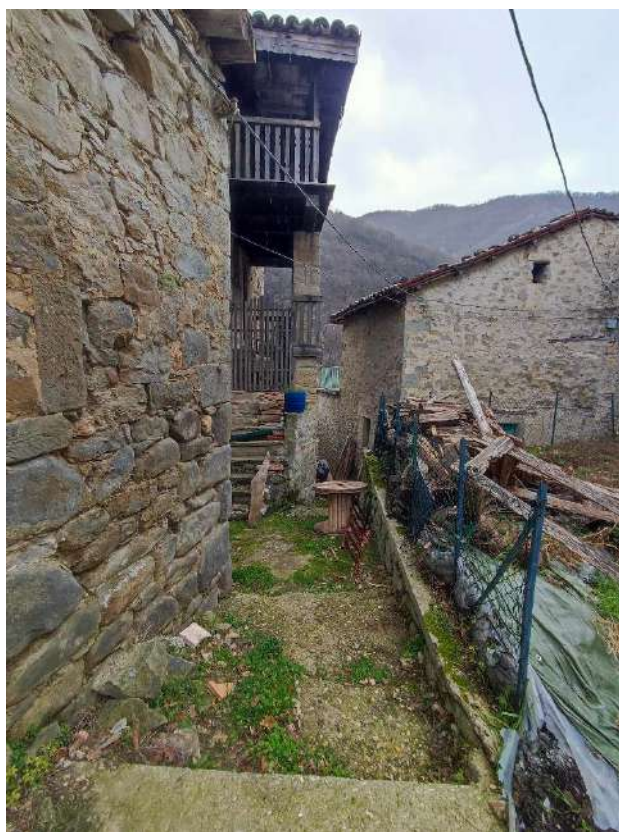
Figura 19: Percorso pedonale interno in cemento
