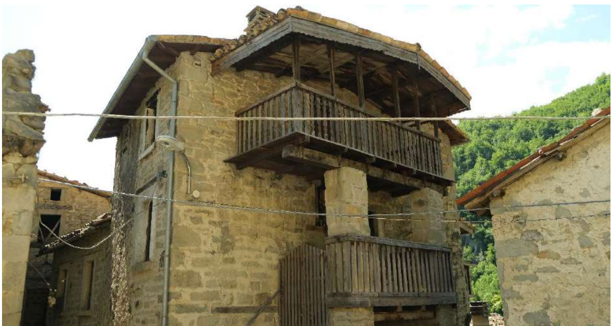
Figura 7: Vista di un balcone in legno
