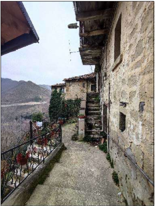
Viabilità pedonale con fondo in cemento
