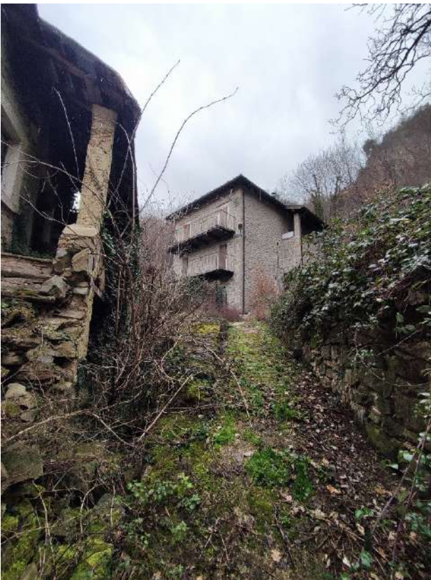
Figura 15: Percorso pedonale interno non pavimentato
