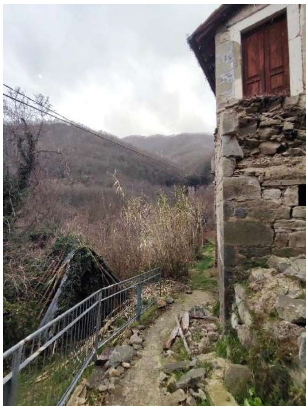
Figura 16: Percorso pedonale interno in cemento
