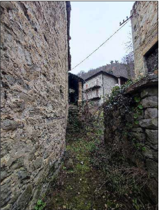
Viabilità pedonale con fondo naturale
