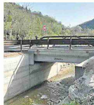
Il ponte sul Cinisco ricostruito
