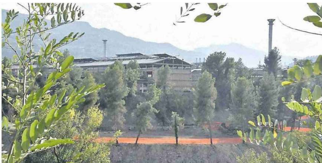
La bonifica della vasca di prima pioggia è stata portata a termine
