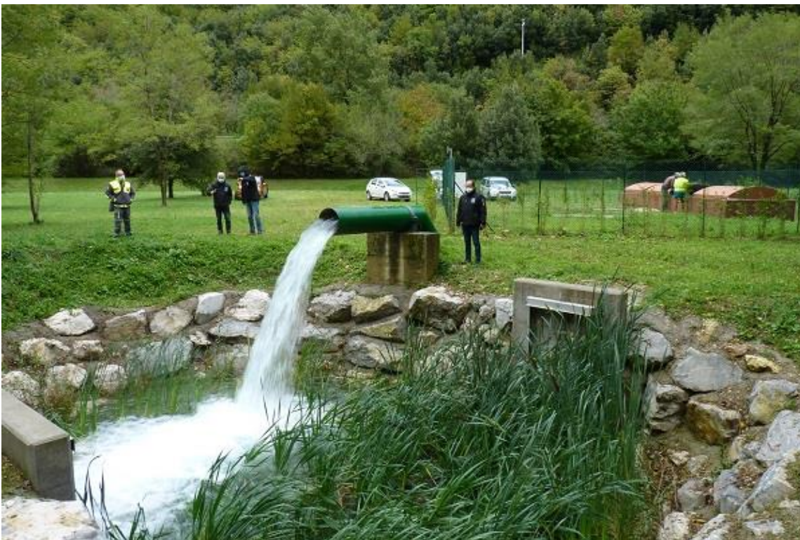
Foto 2. Bacino di dissipazione e, sullo sfondo a destra, la copertura della nuova testa pozzo
