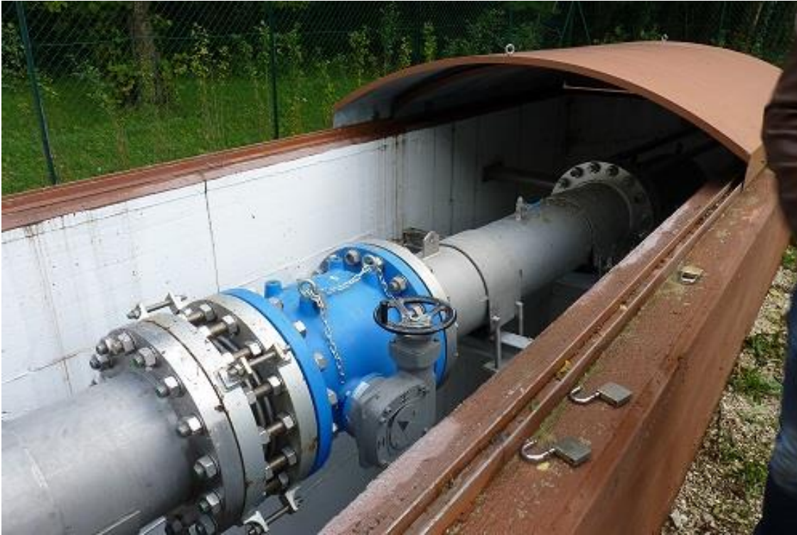
Foto 1. Alloggiamento e tubazioni della nuova testa pozzo
