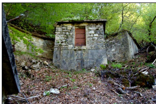
Fig.5.1 – In alto: ubicazione della sorgente Acqua Arva. In basso particolare dell'opera di captazione.
