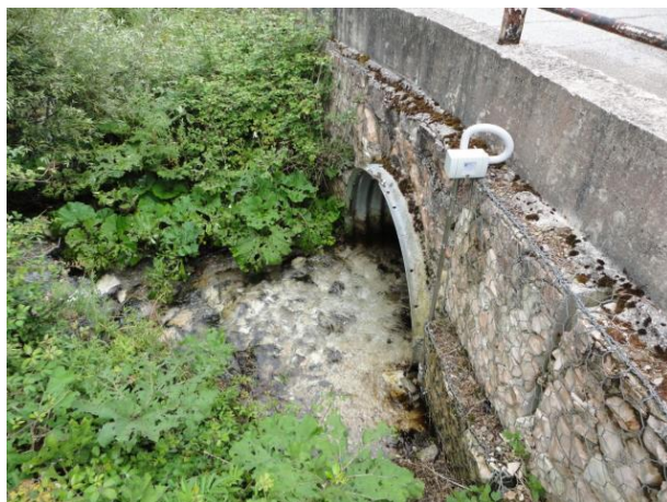
Fig.8.7 – Misuratori di livello installati rispettivamente alla confluenza del fosso di San Giovanni con il torrente Scarzito (a sinistra) e lungo lo stesso fosso in corrispondenza dell'opera di captazione (a destra).
