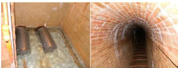
Fig.6.4 – (In alto) il bottino di presa della sorgente Niccolini; (in basso) particolare della galleria e dei dreni.
