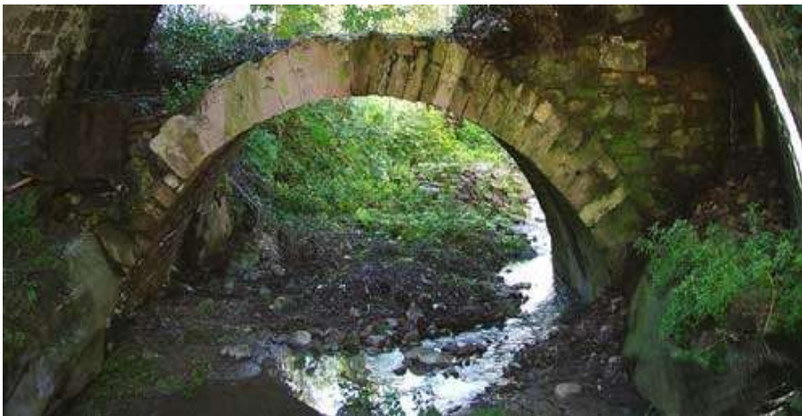
Fig. 13 - Il Rio Nile defluente sotto un ponte romano.
