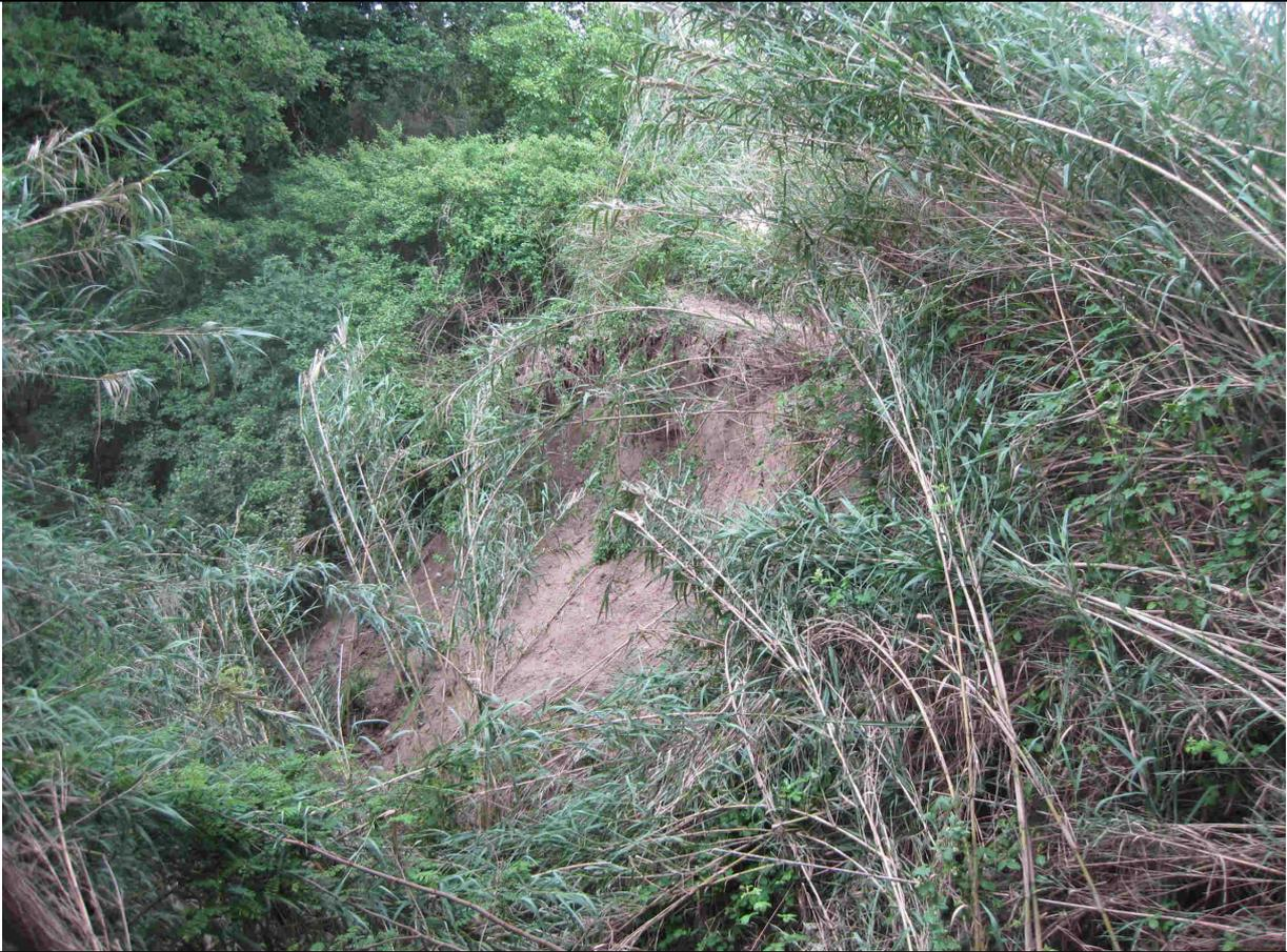
**L** erosione per sormonto senza sfondamento argine dx f. Sambuco in
