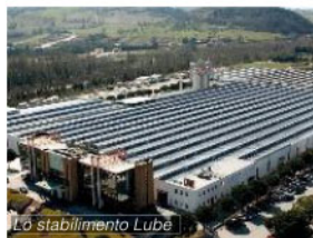
Lo stabilimento Lube
