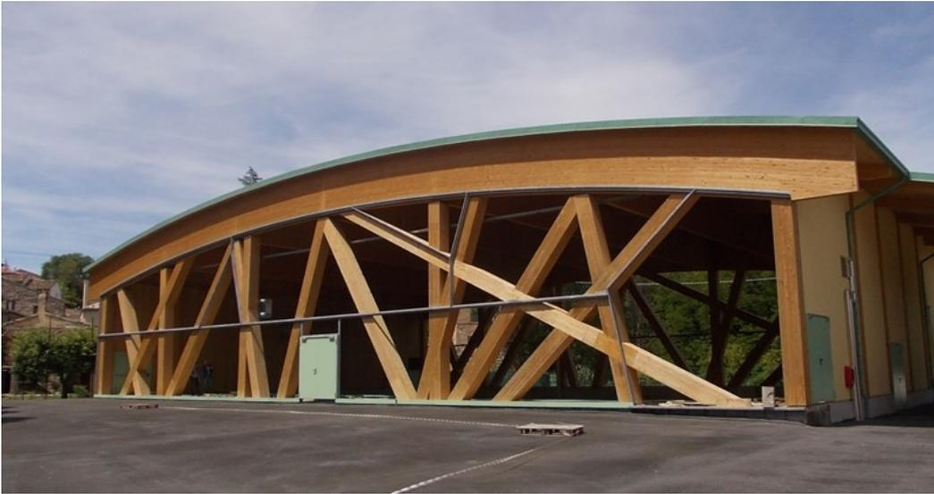
*Nei nuovi edifici i sistemi costruttivi caratterizzati dal legno lamellare nella palestra e dall'acciaio nel ponte acquistano una particolare valenza architettonica*
