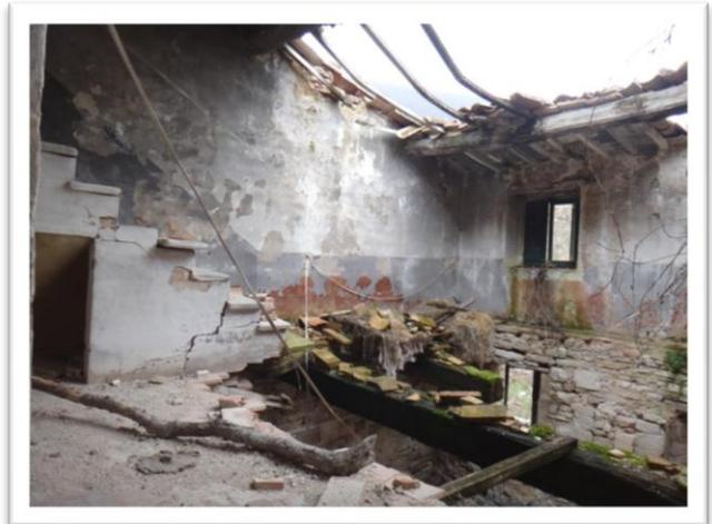
Figura 4-34 - Copertura e solaio crollati
