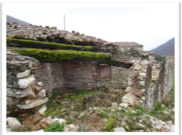
Figura 4-36 - Particolare copertura e muratura crollate edificio pertinenziale
