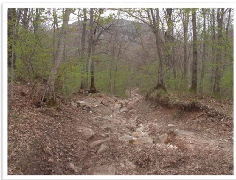
Figura 5-3 – Tracciato 19, danneggiamento del fondo
