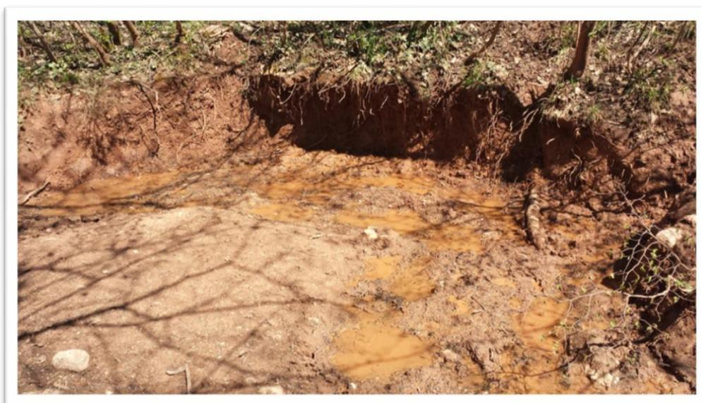
Figura 5-4 – Danneggiamento della pista da parte dei cinghiali
