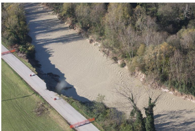
**Figura 41:** Erosione spondale con scalzamento al piede del rilevato stradale SP185 - Fiume Aso
