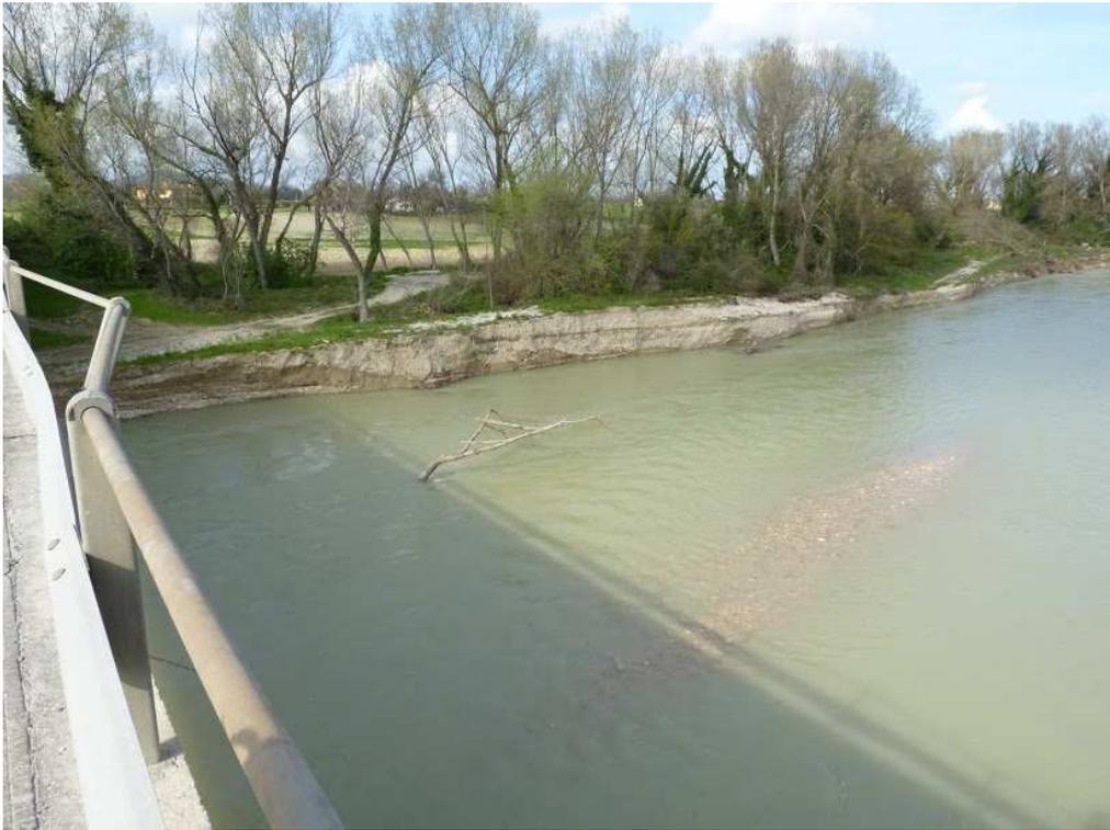
*Figura 43: erosioni spondali – fiume Metauro località Lucrezia*
