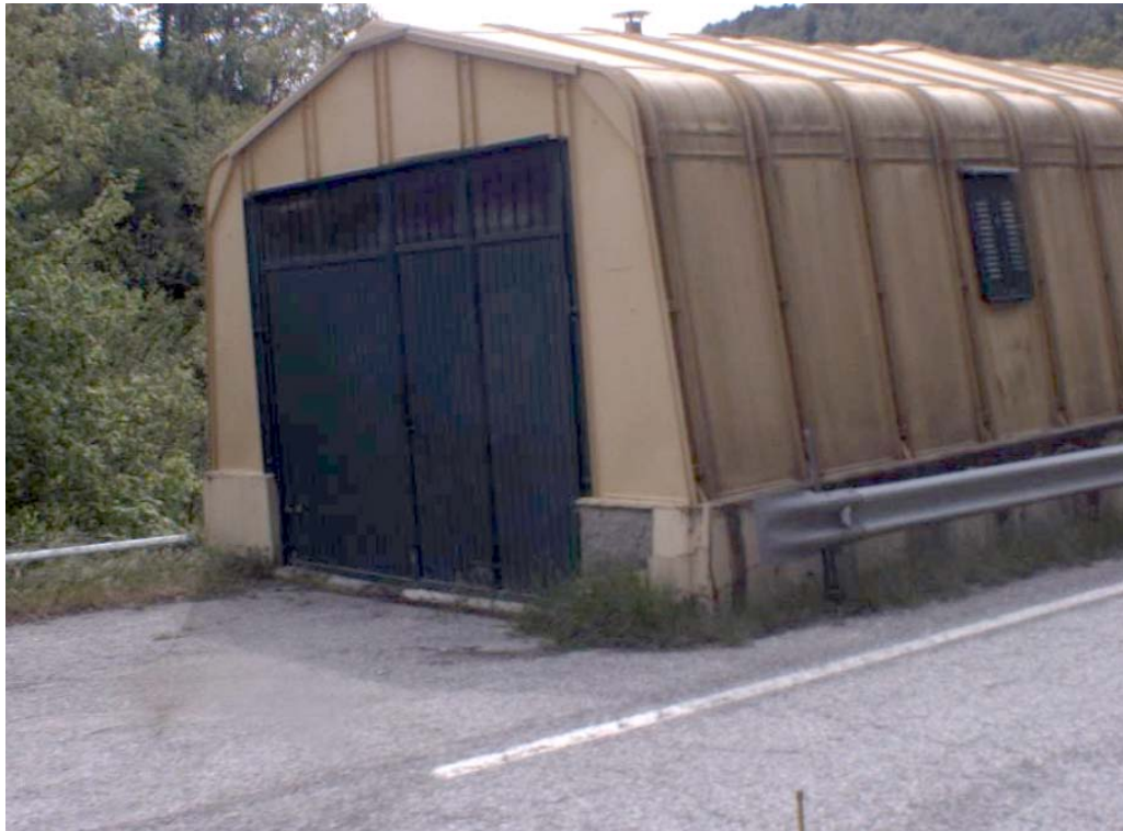
Km 23+091_ Centro operativo
