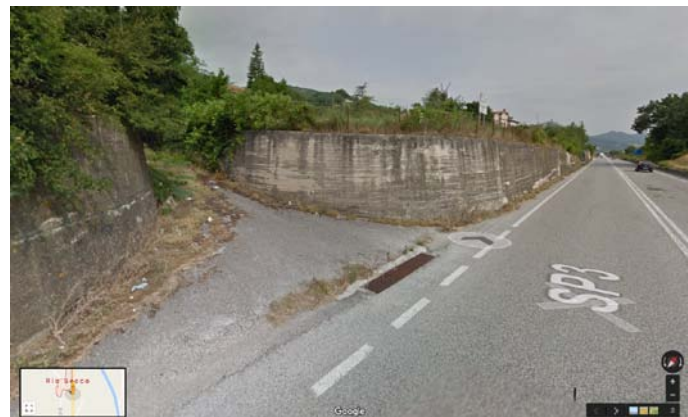
Km 239+547 SP 3 - "Flaminia" – Loc. Rio Secco di Cagli (accesso da S.P. 3 "Flaminia")
