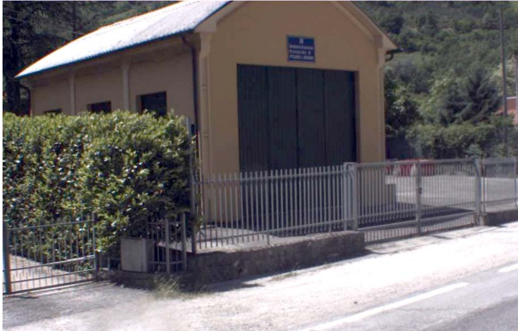
Km 45+273_ centro operativo
