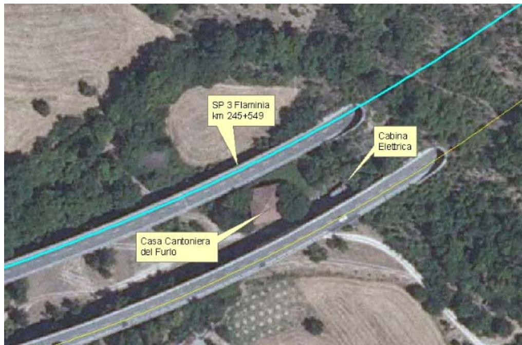
Km 245+549 SP 3 - "Flaminia" –Sottostante i viadotti. Casa Cantoniera e cabina elettrica
