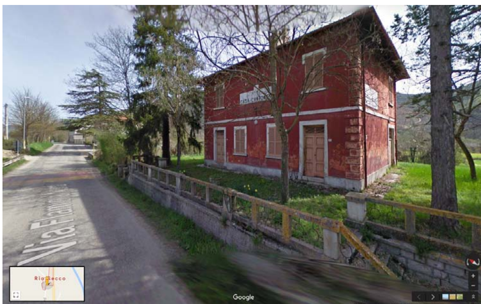
Km 239+547 SP 3 - "Flaminia" – Loc. Rio Secco di Cagli (accesso da Via Flaminia Nord)
