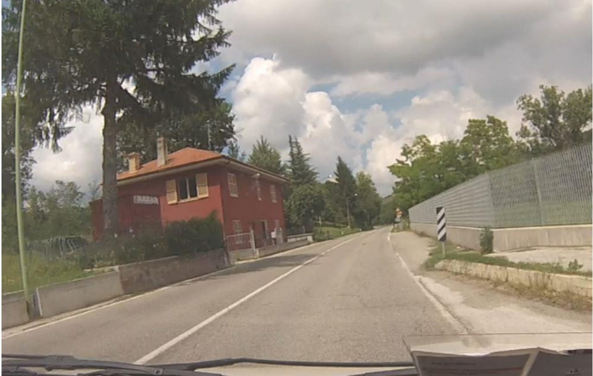
Casa cantoniera - Km. 85+900 -Località Lucciano –Foglio 5 part 88 sub1-2-3-4
