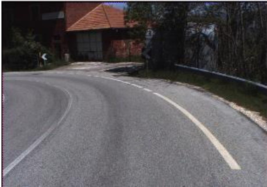
Km 95+045,35 _CASA CANTONIERA_ FIUMINATA Località Passo Cornello Foglio 54 part. 241 sb 3-4-5-6
