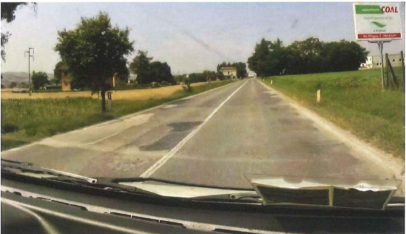
Km. 10+300 - Asfalto in parte usurato e ammalorato
