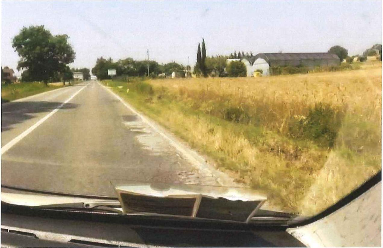
Km. 10+250 - Asfalto in parte usurato e ammalorato
