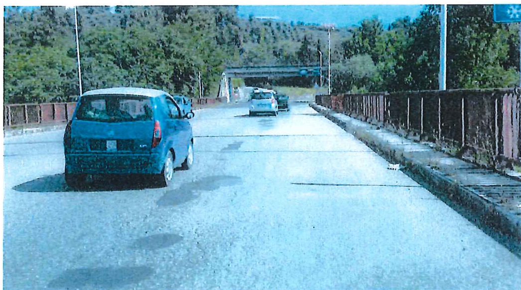
S.P 236 (Dir. Monticelli - Ponte su Fiume Tronto)
