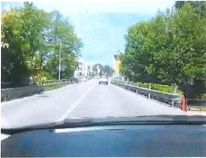
01 - Km 05+555 SP 424 - PONTE Frazione Ponte ...
