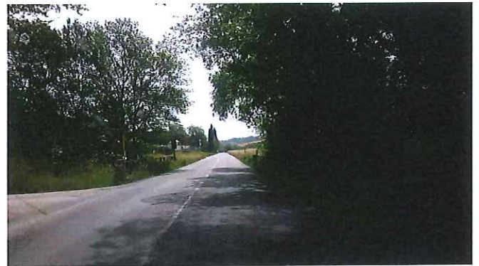
04 - Km 11+300 S.P. 362 JESINA PONTE.jpg
