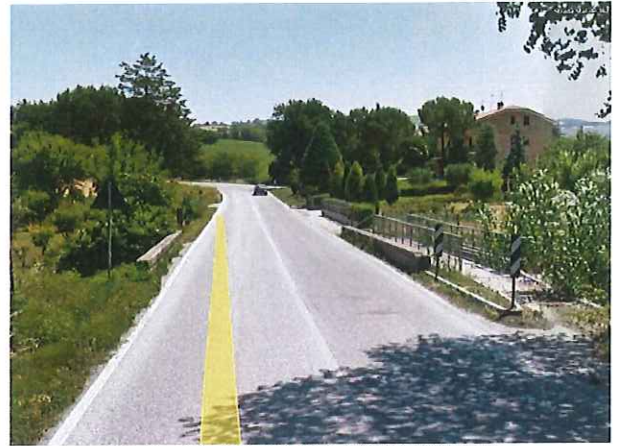
02 - Km 01+440 S.P. 362 JESINA PONTE.jpg
