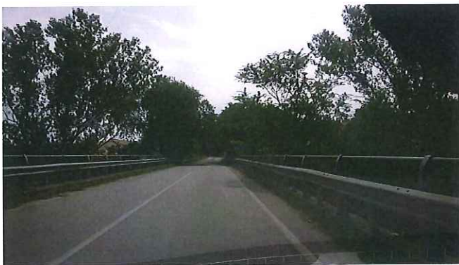
87 - Km 20+200 S.P. 362 JESINA PONTE.jpg
