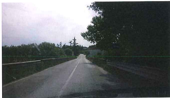
45 - Km 09+300 S.P. 362 JESINA PONTE.jpg
