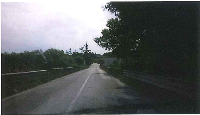
03 - Km 09+300 S.P. 362 JESINA PONTE.jpg
