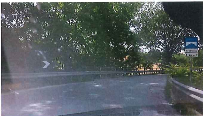
05 - Km 12+200 S.P. 362 JESINA PONTE.jpg
