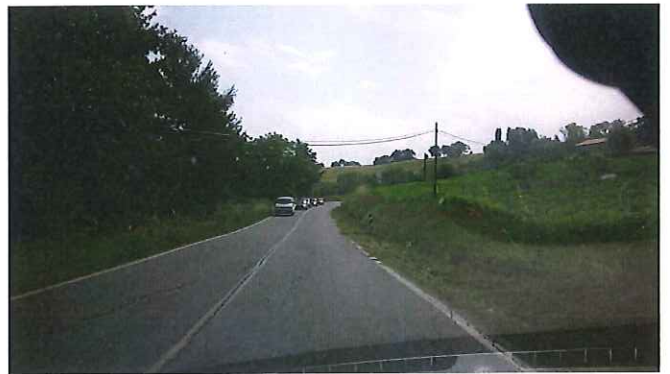
24 _ Km 04+550 S.P.362 JESINA FRANA.jpg
