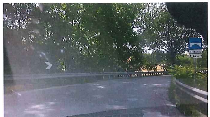
56 - Km 12+200 S.P. 362 JESINA PONTE.jpg
