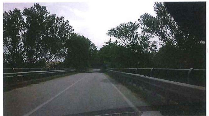
06 - Km 20+200 S.P. 362 JESINA PONTE.jpg
