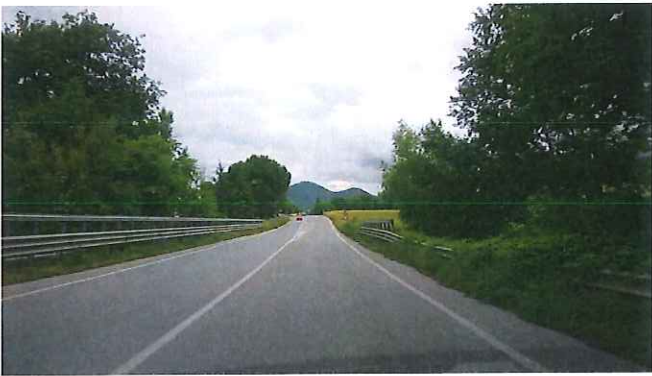
03 - Km 32+702 PONTE S.P. 256 MUCCESE.jpg
