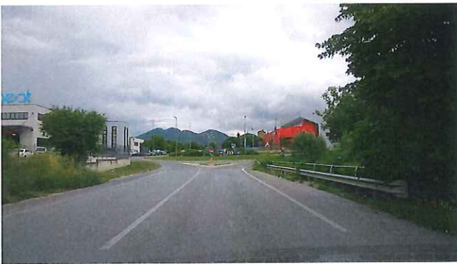
05 - Km 33+125 PONTE S.P. 256 MUCCESE.jpg
