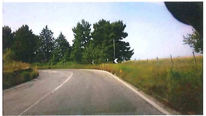
32 - KM 06+150 S.P. 502 DI CINGOLI.jpg
