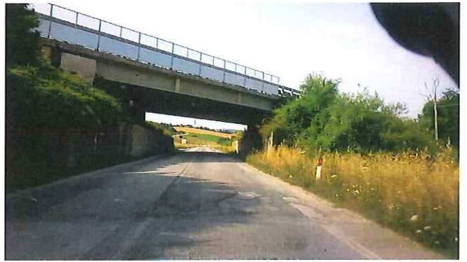
04 - KM 02+300 S.P. 502 DI CINGOLI SOVRAPPASSO SS 76.jpg
