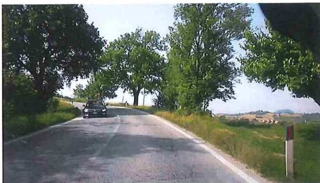
45 - KM 08+200 S.P. 502 DI CINGOLI.jpg
