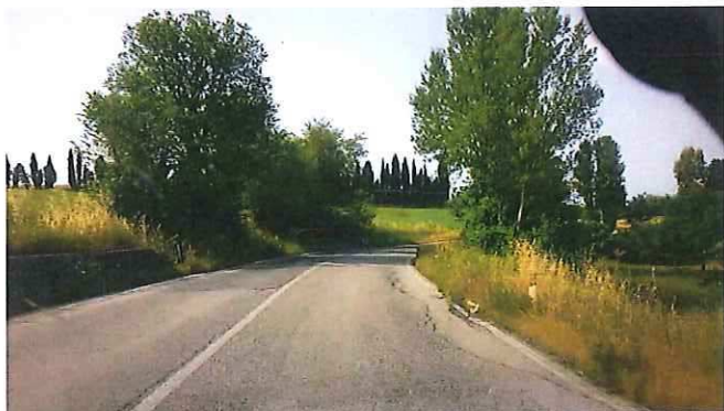
14 - KM 03+900 S.P. 502 DI CINGOLI.jpg
