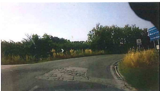
23 - KM 05+000 S.P. 502 DI CINGOLI.jpg
