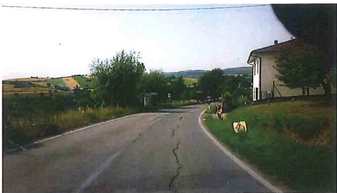
59 - KM 10+750 S.P. 502 DI CINGOLI.jpg
