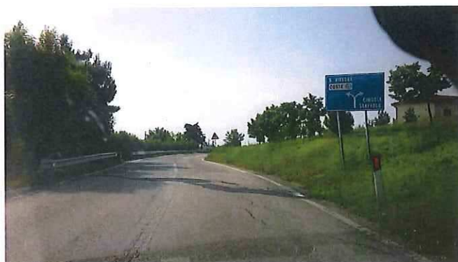
47 - KM 08+400 S.P. 502 DI CINGOLI.jpg
