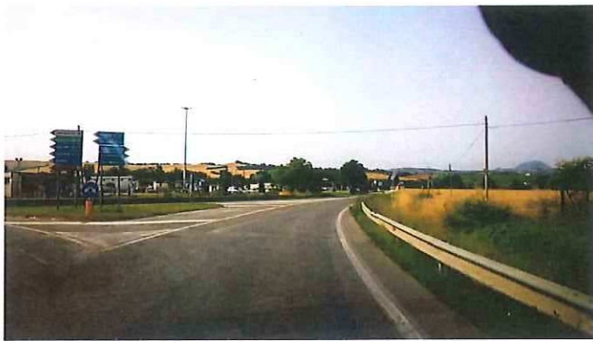
01 - Km 01+770 INIZIO S.P. 502 DI CINGOLI.jpg
