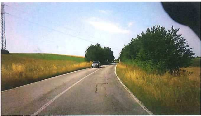
07 - KM 02+800 S.P. 502 DI CINGOLI.jpg
