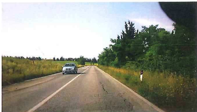
12 - KM 03+500 S.P. 502 DI CINGOLI.jpg
