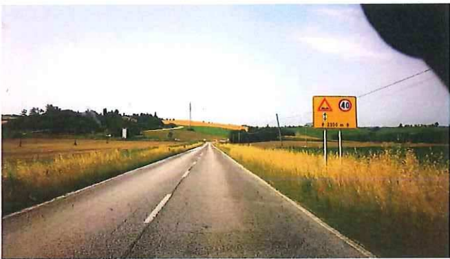
05 - KM 02+500 S.P. 502 DI CINGOLI.jpg
