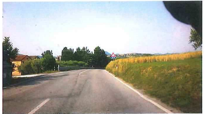
42 - KM 07+400 S.P. 502 DI CINGOLI.jpg
