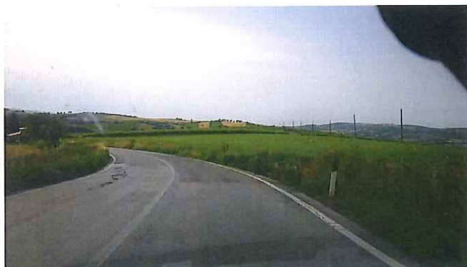
55 - KM 10+100 S.P. 502 DI CINGOLI.jpg
