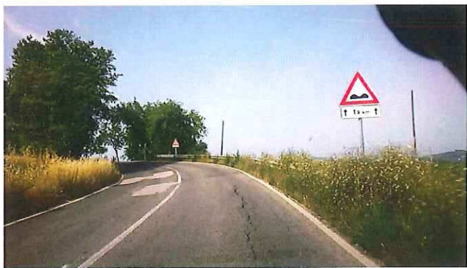
24 - KM 05+100 S.P. 502 DI CINGOLI.jpg
