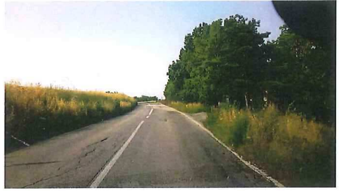
26 - KM 05+250 S.P. 502 DI CINGOLI.jpg
