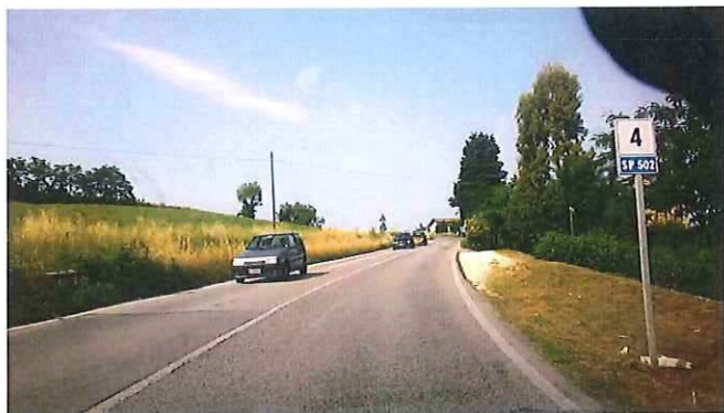
16 - KM 04+000 S.P. 502 DI CINGOLI.jpg
