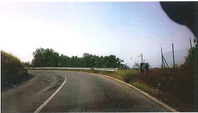
27 - KM 05+300 S.P. 502 DI CINGOLI RIGONF. CENTRO STRADA.jpg
