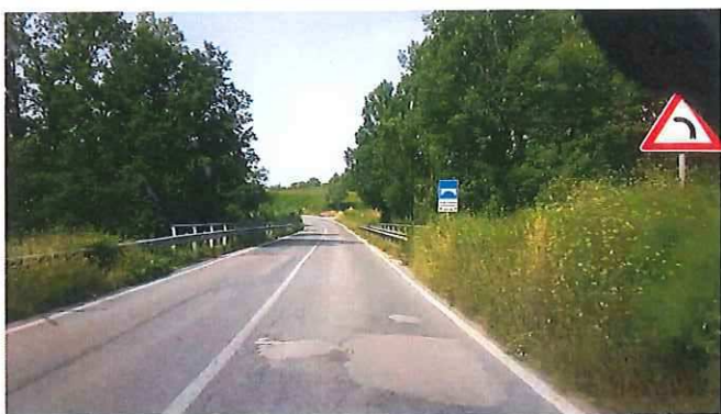
62 - KM 11+248 S.P. 502 DI CINGOLI PONTE BRECCIONE.jpg
