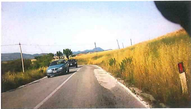
41 - KM 07+100 S.P. 502 DI CINGOLI.jpg
