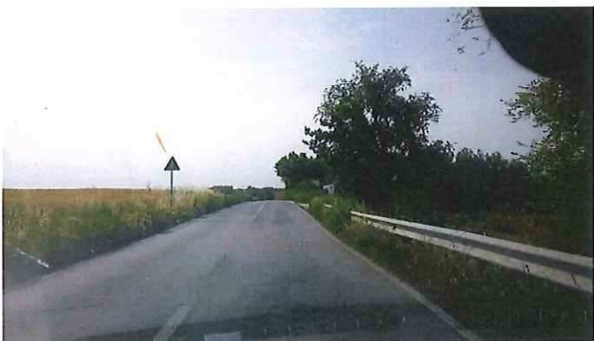
29 - KM 05+450 S.P. 502 DI CINGOLI.jpg
