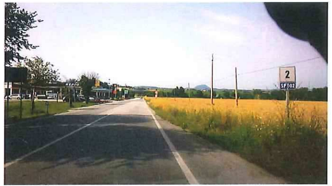
02 - KM 02+000 S.P. 502 DI CINGOLI.jpg
