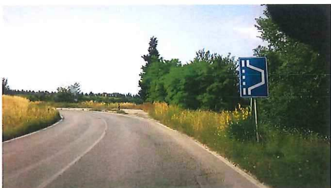
11 - KM 03+300 S.P. 502 DI CINGOLI.jpg
