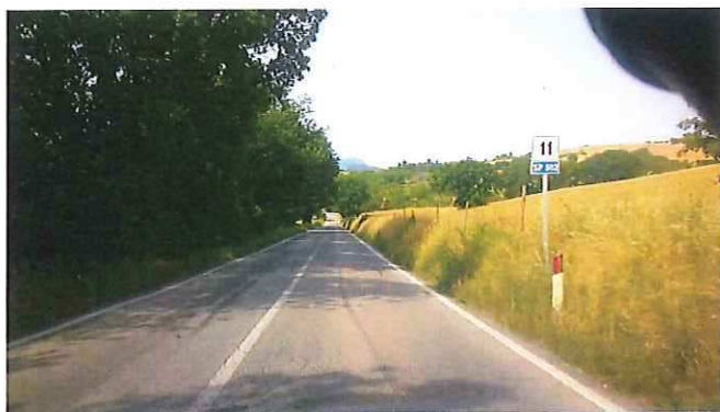
61 - KM 11+000 S.P. 502 DI CINGOLI.jpg
