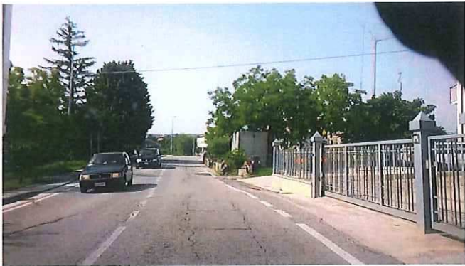
51 - km 09+300 S.P. 502 DI CINGOLI.jpg
