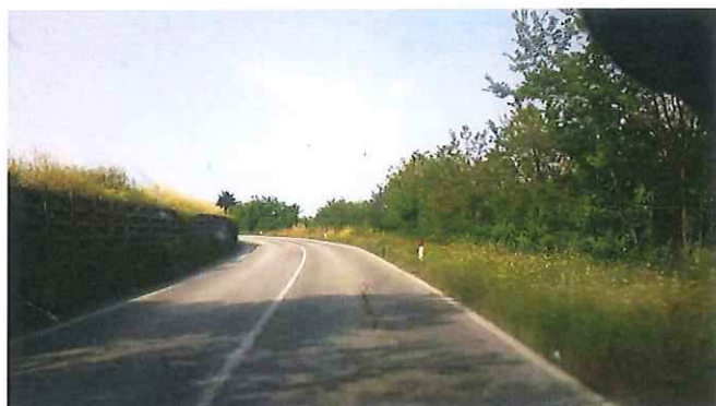
10 - KM 03+150 S.P. 502 DI CINGOLI.jpg
