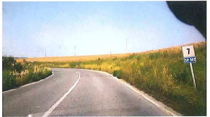
40 - KM 07+000 S.P. 502 DI CINGOLI.jpg
