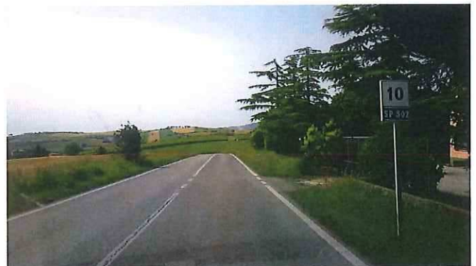
54 - KM 10+000 S.P. 502 DI CINGOLI.jpg
