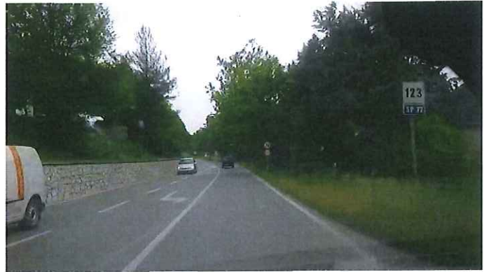
20 - Km 123+000 S.P. 77 VAL DI CHIANTI.jpg
