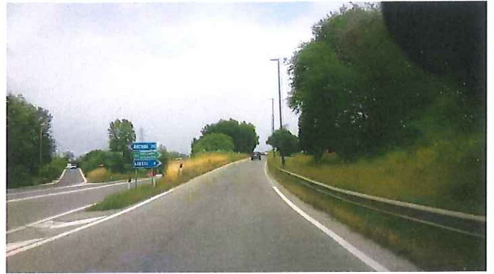
26 - Km 124+325 (2) S.P. 77 VAL DI CHIANTI RAMPA DI ACCESSO DA ...
