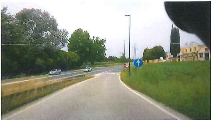
29 - Km 124+325 (5) S.P. 77 VAL DI CHIANTI RAMPA IN USCITA DI AC...
