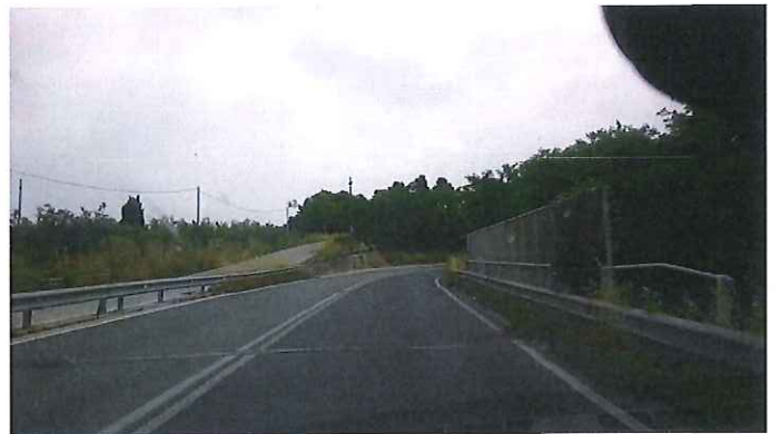
22 - Km 123+620 S.P. 77 VAL DI CHIANTI VIADOTTO SU SS 16.jpg
