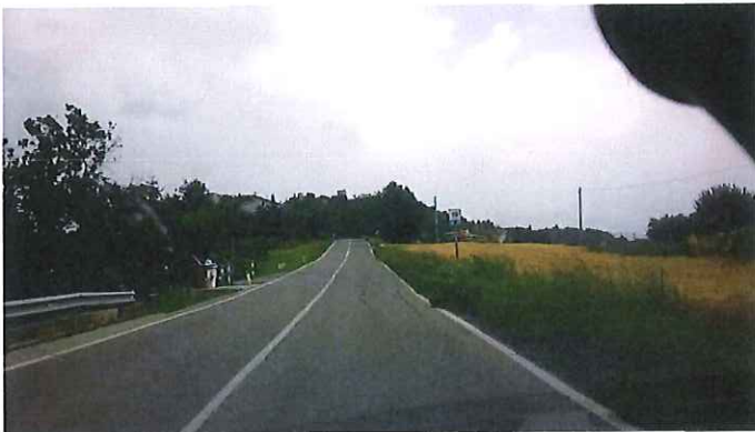
05 - Km 119+000 S.P. 77 VAL DI CHIANTI Frana.jpg
