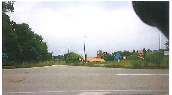
28 - Km 124+325 (4) S.P. 77 VAL DI CHIANTI RAMPA IN USCITA DI AC...
