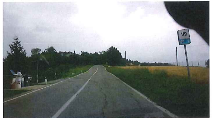
06 - Km 119+000 (2) S.P. 77 VAL DI CHIANTI Frana.jpg
