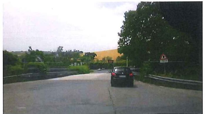
24 - Km 124+325 S.P. 77 VAL DI CHIANTI VIADOTTO.jpg
