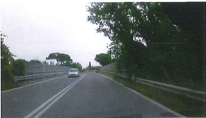
21 - Km 123+480 S.P. 77 VAL DI CHIANTI VIADOTTO SU A14.jpg
