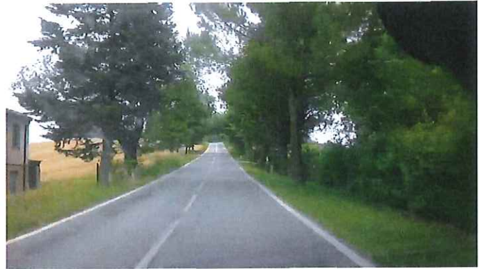
04 - Km 118+600 S.P. 77 VAL DI CHIANTI.jpg
