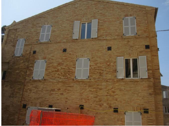
*Palazzo Marinelli è l'intervento più significativo del programma. Nell'adeguamento sismico sono stati utilizzati diversificati dispositivi di ancoraggio (chiavitranti). Anche in questo caso esteso utilizzo del legno per gli orizzontamenti*
