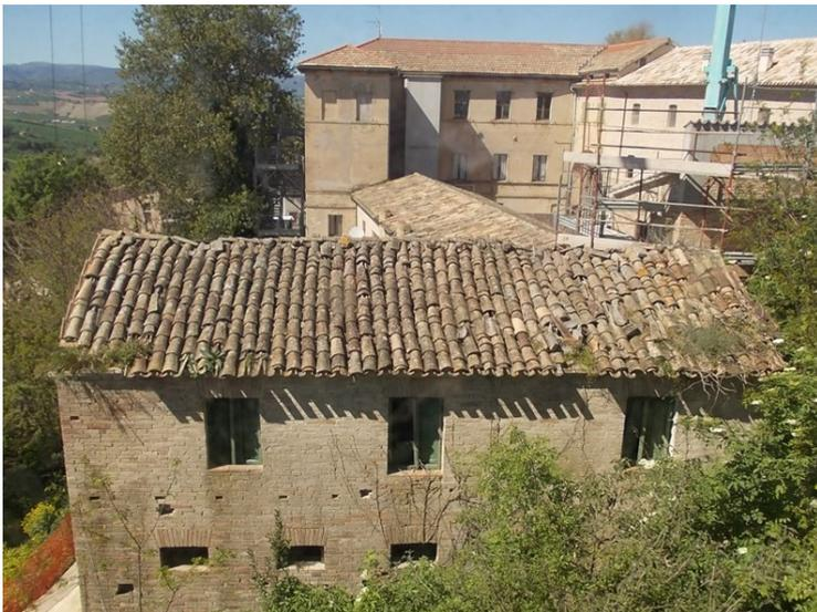
*Il recupero in corso del complesso edilizio è caratterizzato dal ripristino-integrazione delle strutture in laterizio, integrate da solai e coperture in legno*
