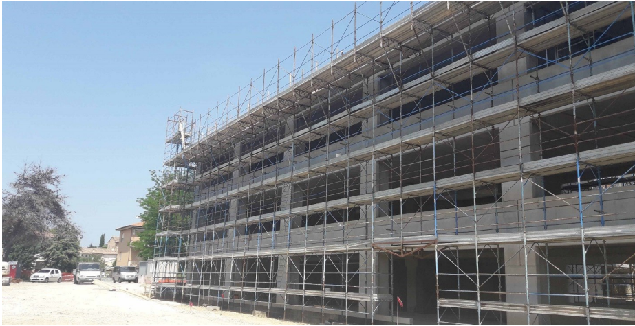
Prospetto principale edificio durante i lavori
