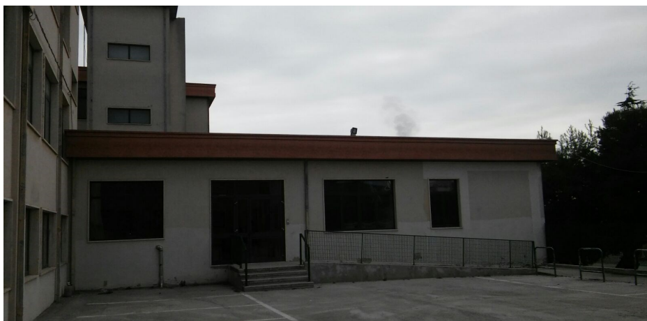
Particolare rampa di accesso
