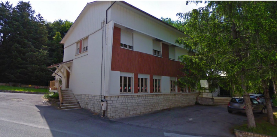
Prospetto principale edificio
