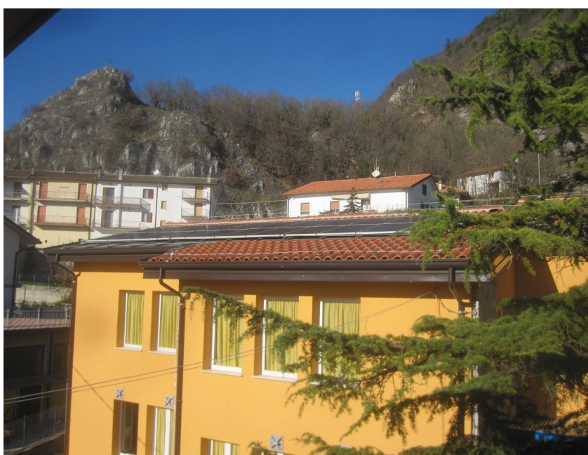
Pannelli del nuovo impianto fotovoltaico installati sulla copertura
