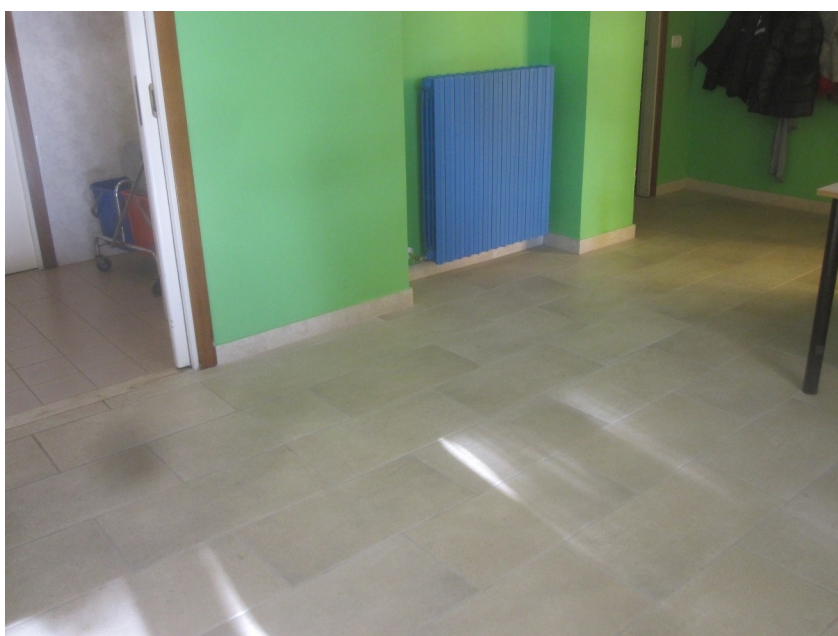
Particolare della nuova pavimentazione
