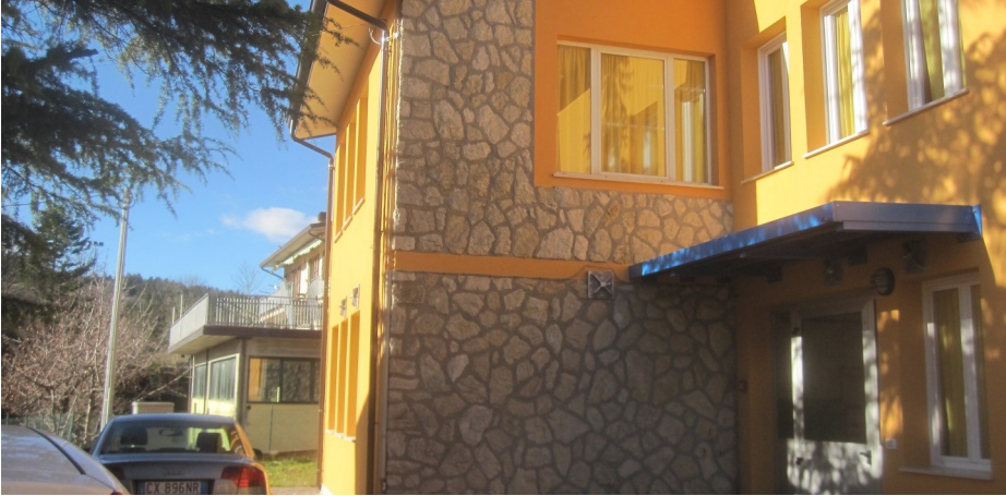
Prospetto principale edificio
