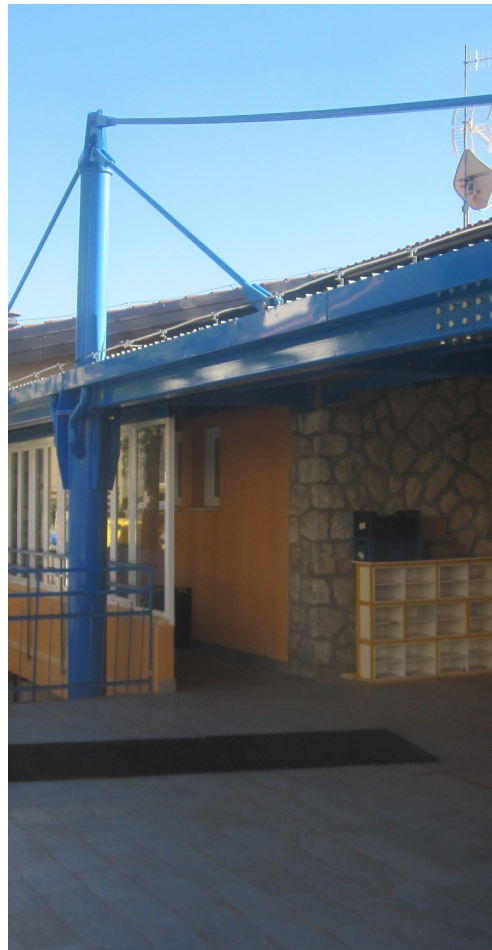
Miglioramento sismico: cordolo tirante in acciaio di estradosso
