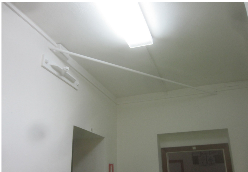
Tirante inserito per l'intervento di miglioramento sismico
