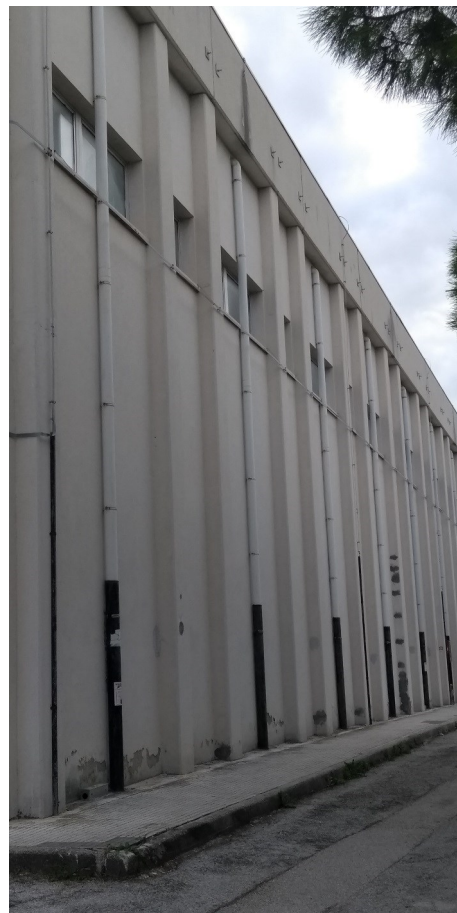
Prospetto principale edificio
