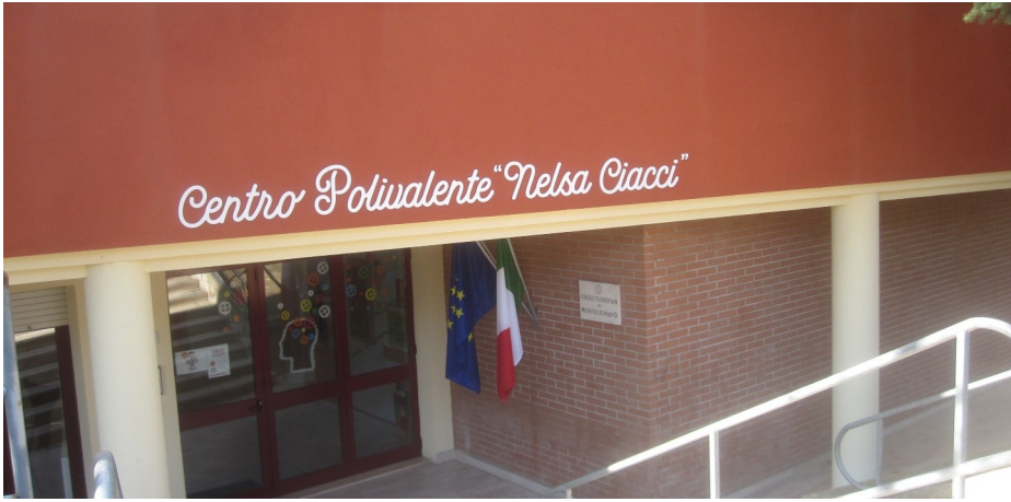
Prospetto principale dell'edificio...
