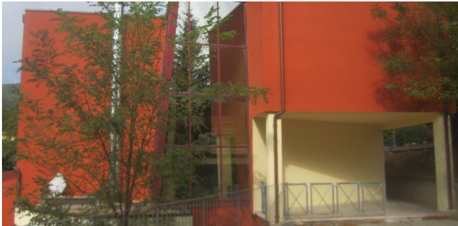
Prospetto laterale dell'edificio
