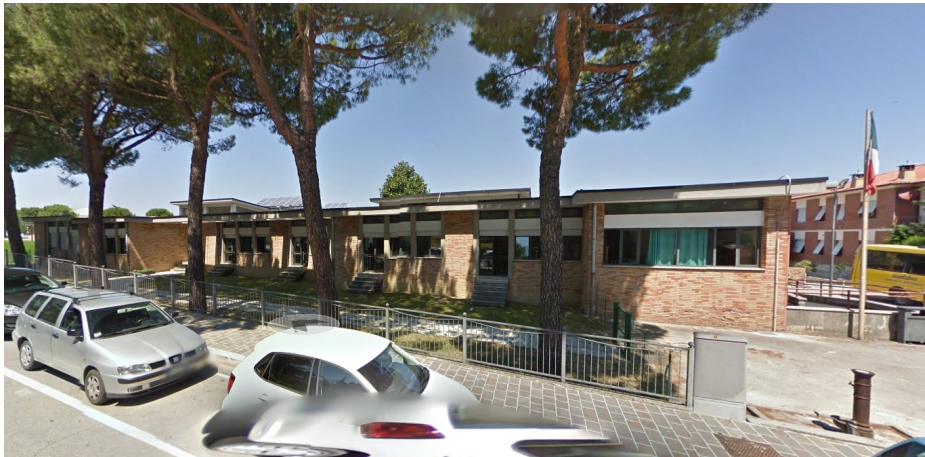
Foto da sostituire
