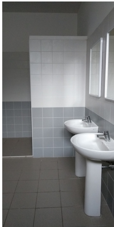
Foto da sostituire
