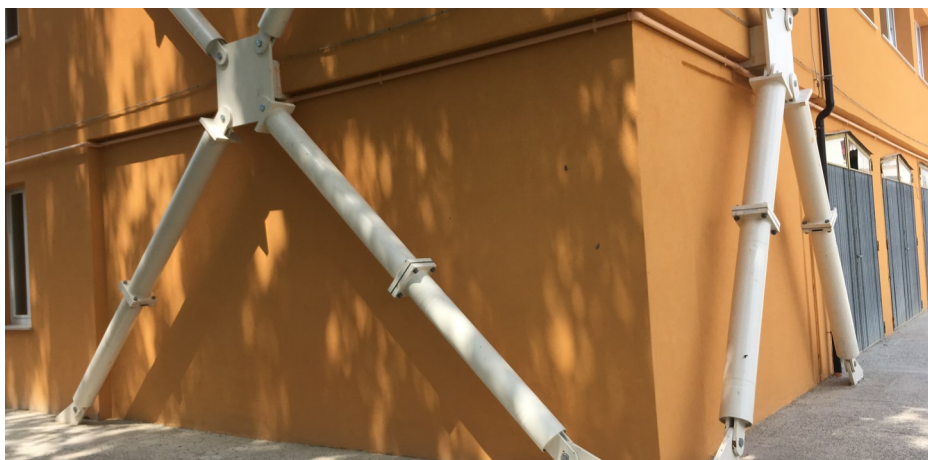
Intervento antisismico—particolare
