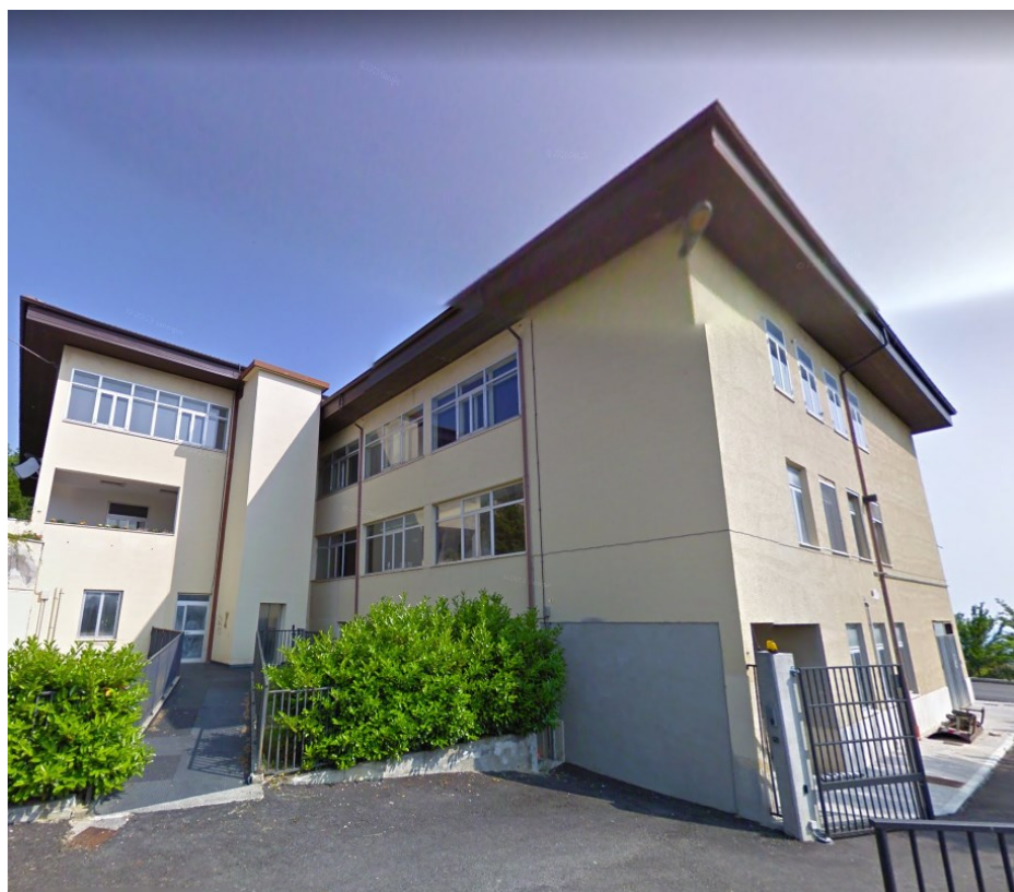
Prospetto laterale edificio
