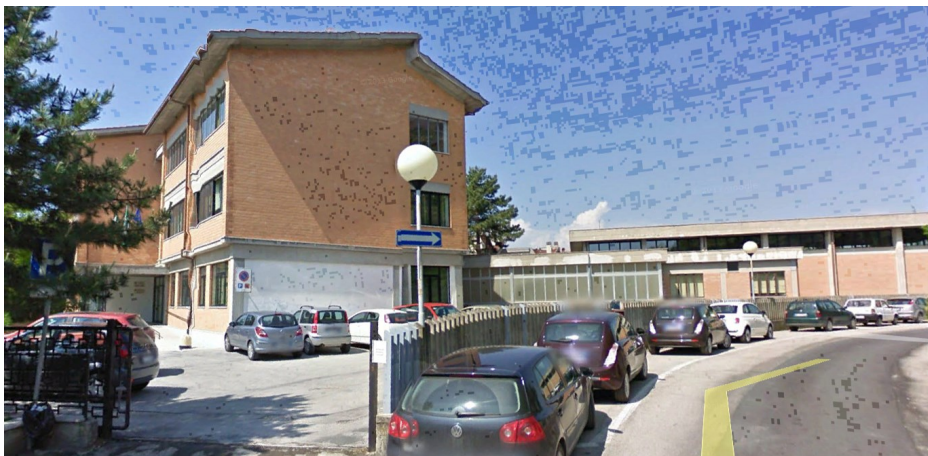
Prospetto principale edificio
