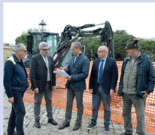
Sopralluogo dell'assessore Aguzzi per l'avvio dei lavori sul Ponte Garibaldi
