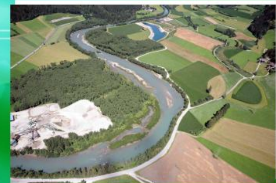
Fine lavori III lotto (maggio 2011)
