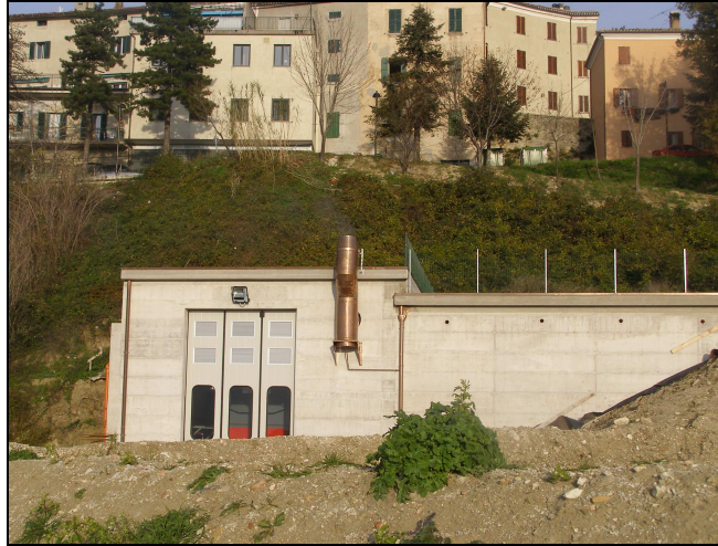
Figura 8 – Caldaia a biomassa di piccola-media potenza
