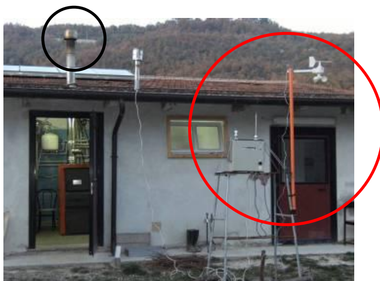
Figura 1 – Area di campionamento, cerchiato in rosso l'apparato di campionamento Environcheck e cerchiato in nero il camino del combustore.
