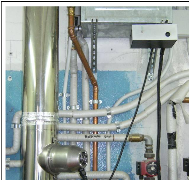
5. centralina di controllo con spie di segnalazione
