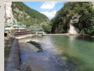
Preso in derivazione per la centrale idroelettrica della cartiera di Pioraco
