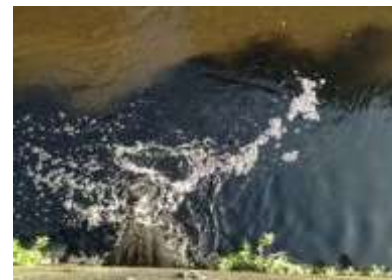
Troppo pieno fognario con scarico a fiume.
